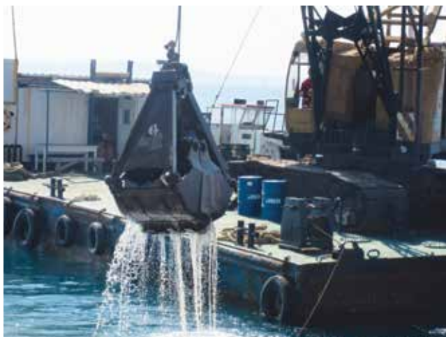
Radovi na iskopu
