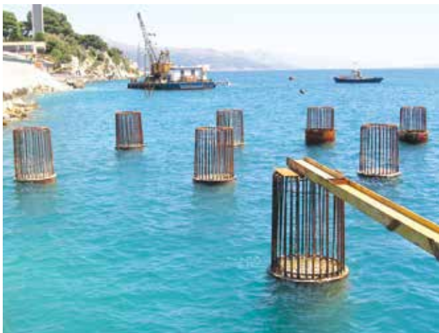
Dio izvedenih bušenih pilota
