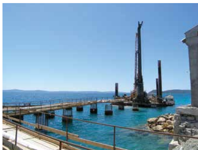
Gradilište budućih trajektnih rampi snimljenog tijekom obilaska
