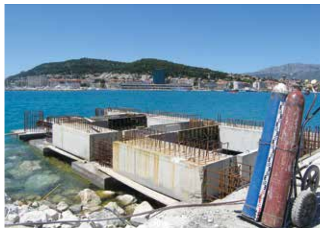
Radovi na utvrđici tijekom obilaska
