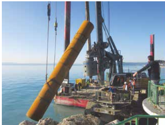
Detalj ugradnje bušenog pilota
