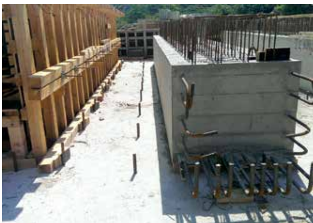
Izvođenje predgotovljenih elemenata u pogonu na Stinicama
