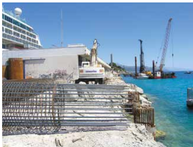
Detalj gradilišta tijekom obilaska
