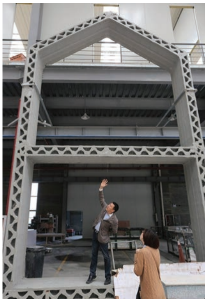
Isprintani betonski element od recikliranog materijala
