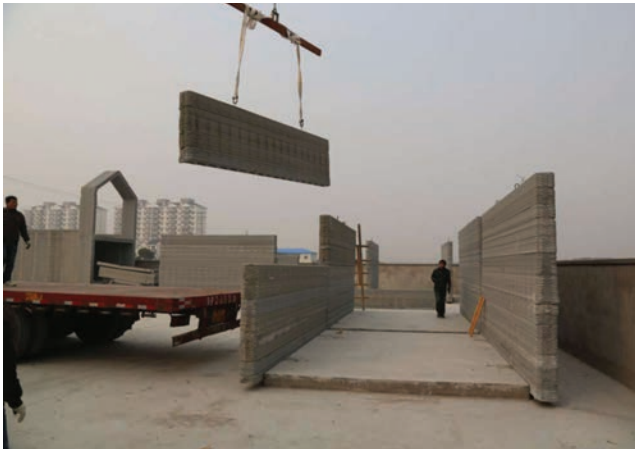
Detalj s gradilišta u Šangaju
