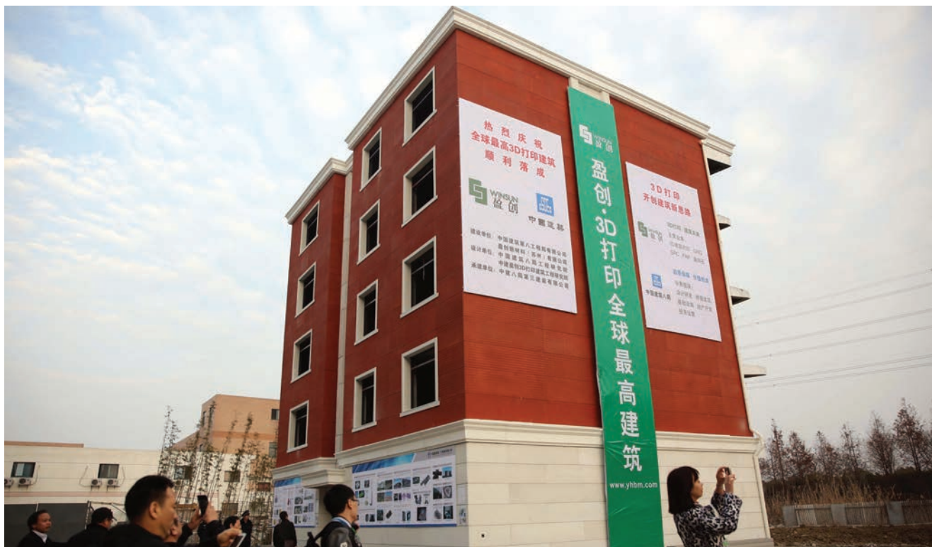
Pogled na četverokatnicu izrađenu modularnom tehnologijom
