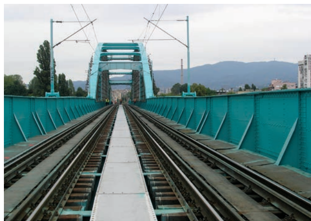
Pogled na prugu i most s pozicije južnog upornjaka
