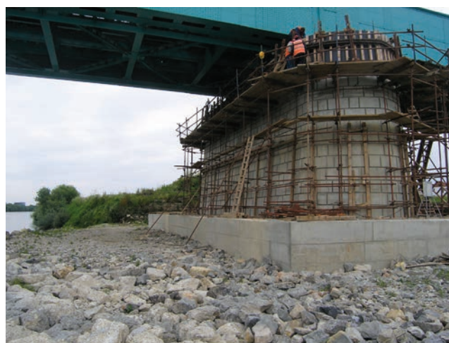
Radovi na ojačavanju stupa C
