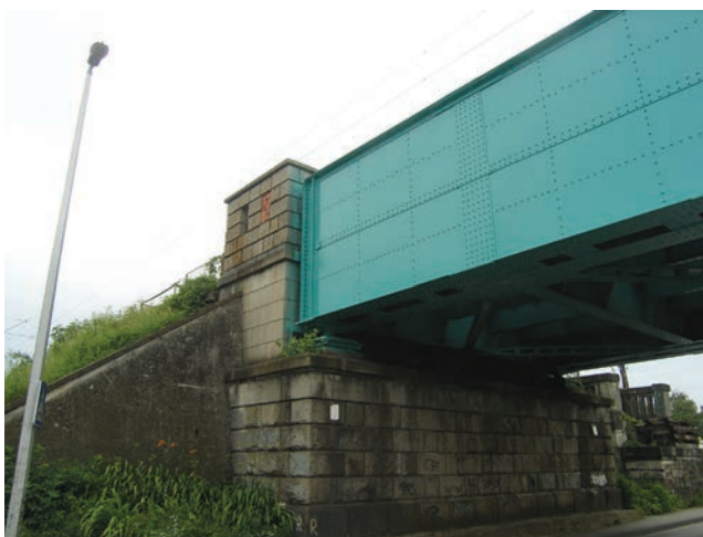
Južni upornjak mosta (desno dolje ostaci upornjaka starog mosta)
