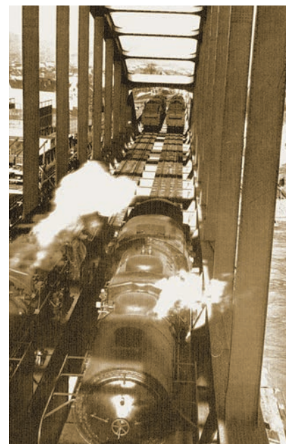
Detalj probnog opterećenja novoizgrađenog mosta
