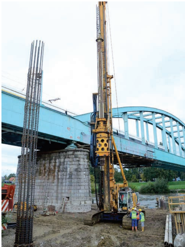
Pobijanje pilota uz stup mosta
