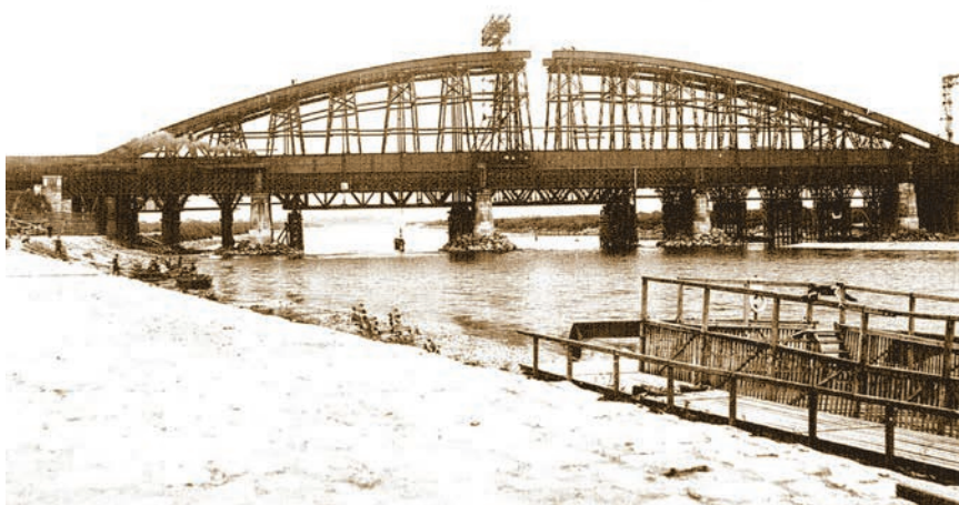
Završno spajanje lukova na mostu
