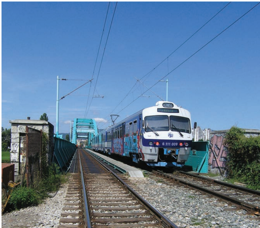
Prolazak vlaka preko mosta tijekom radova
