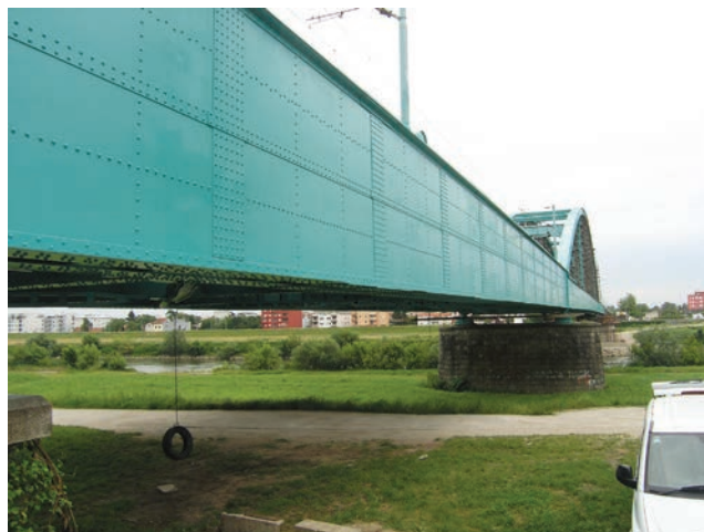
Most i gradilište u daljini s pozicije sjevernog upornjaka
