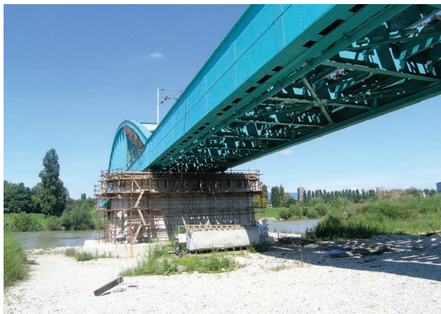
Ojačani stup snimljen tijekom drugog posjeta
