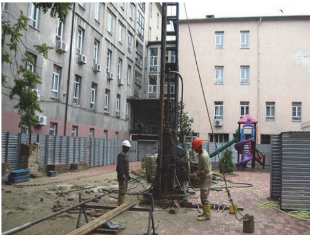
Slika 11. Injektiranje radi ojačanja tla
