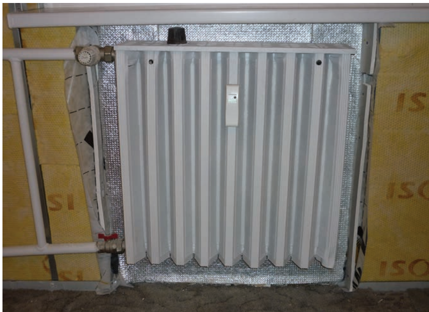
Aerogel Spaceloft može se upotrijebiti i za toplinsku izolaciju zida iza radijatora
