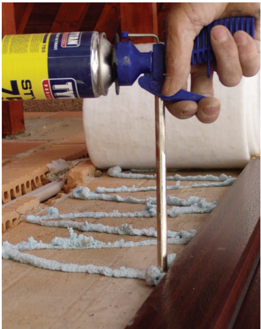
Priprema za nanošenje aerogela Spaceloft na podlogu
