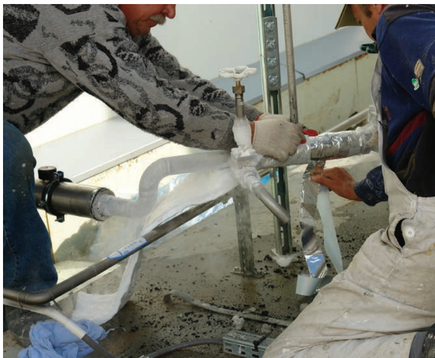
Primjer izolacija instalacijskih cijevi Spaceloftom
