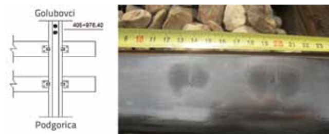
Slika 8. Višestruko squat oštećenje (tipičan oblik "pluća")
