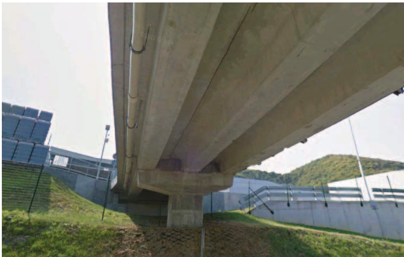
Krak mosta prema tvornici
