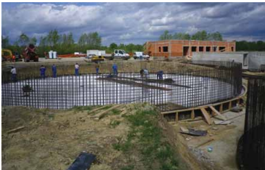
Gradnja uređaja za pročišćavanje u Slavonskom Brodu
