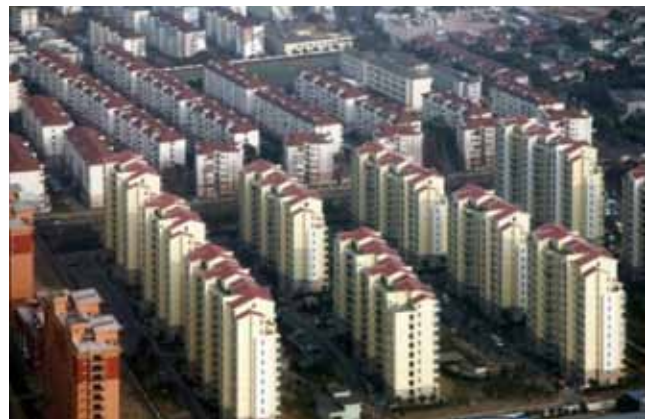
Dio novourbaniziranih dijelova grada Ordosa
