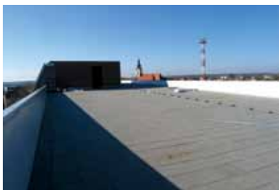
Obnovljeni krov zgrade PIK-a Vinkovci
