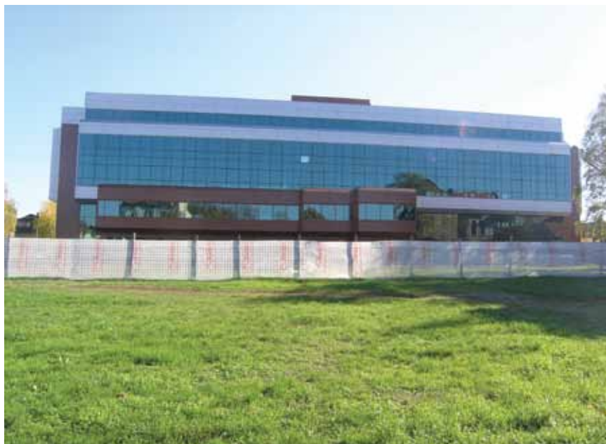
Obnovljeno glavno pročelje zgrade PIK-a Vinkovci
