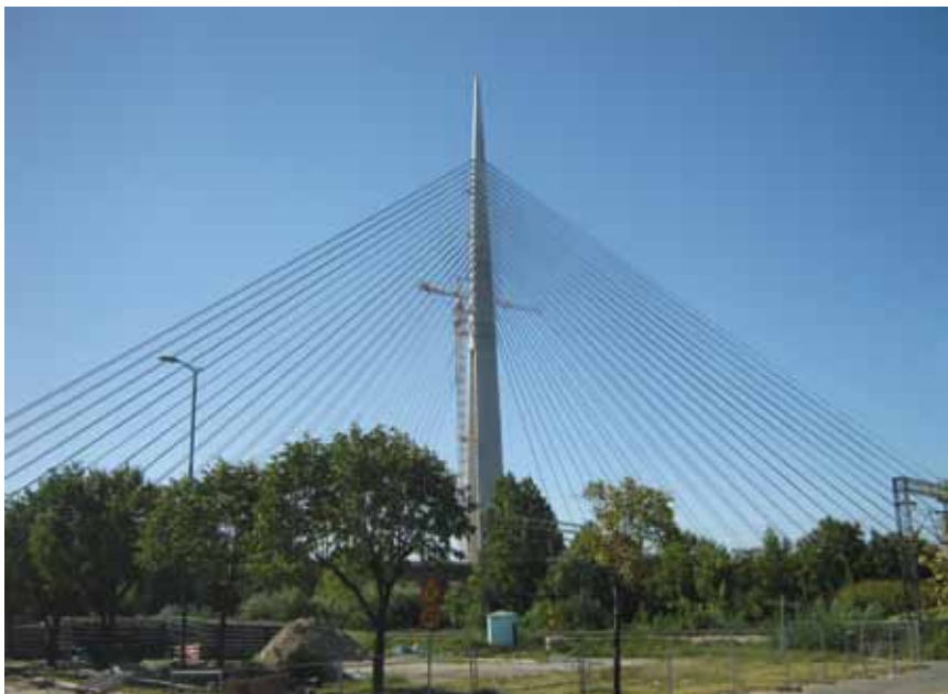
Završni radovi na gradnji mosta
