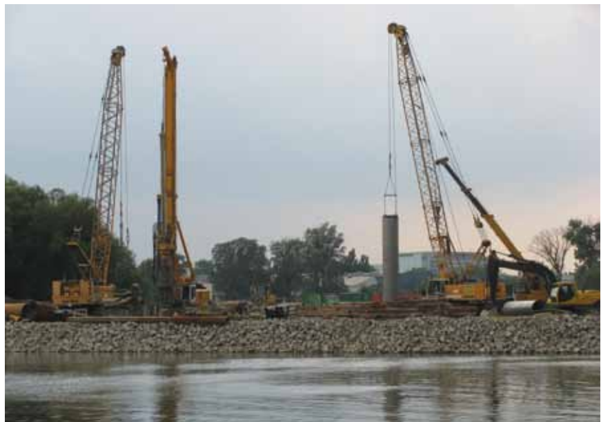
Radovi na temeljenju mosta
