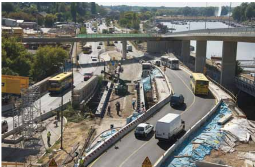
Gradnja prilaznih cesta
