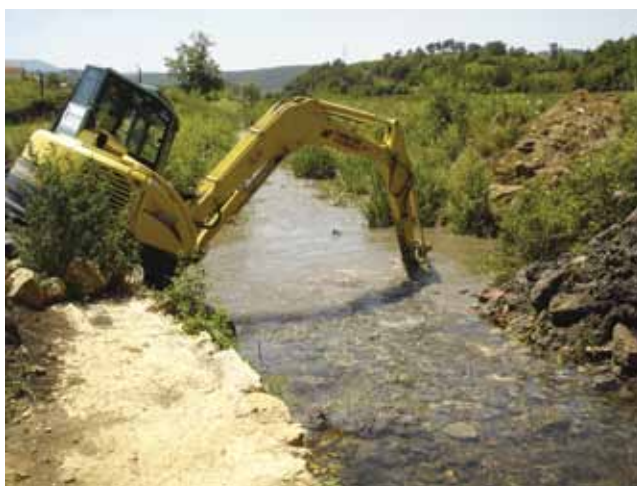
Detalj s početka radova obnove vodoopskrbne i kanalizacijske mreže
