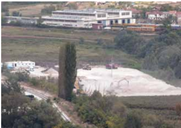
Nasipavanje šljunčanog materijala na lokaciji budućeg uređaja
