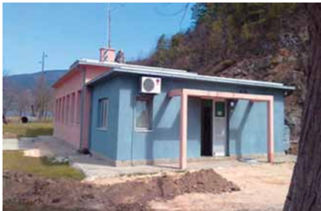
Glavno kninsko vodocrpilište Šimića vrelo
