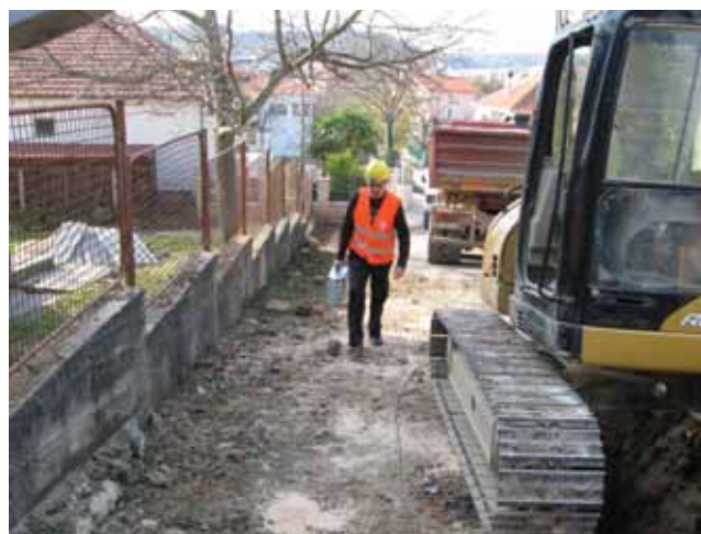
Radovi u jednoj strmoj kninskoj ulici
