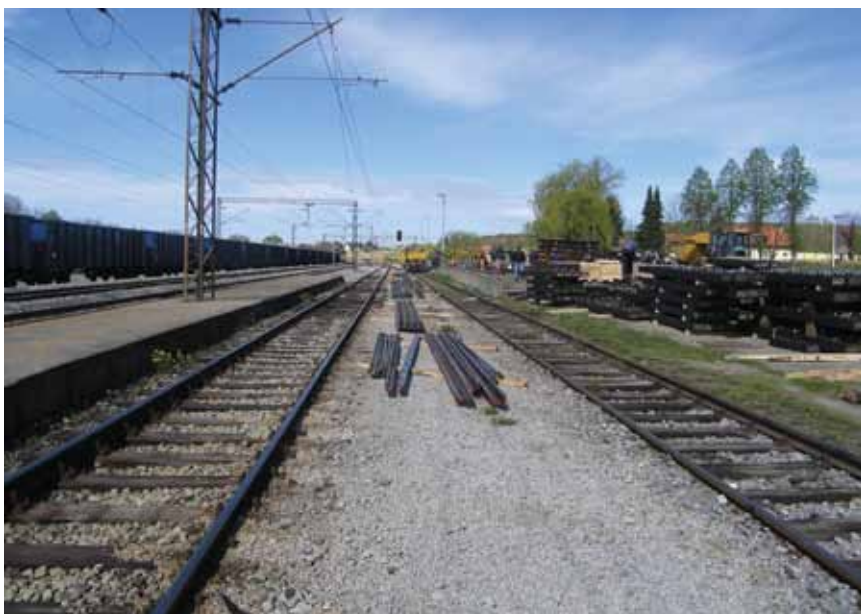
Pogled na gradilište u kolodvoru Lepavina
