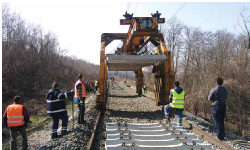
Ugradnja armiranobetonskih pragova
