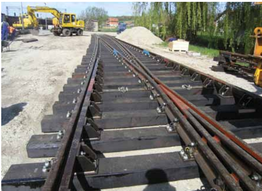
Prikaz ugradnje skretnice u kolodvoru Lepavina
