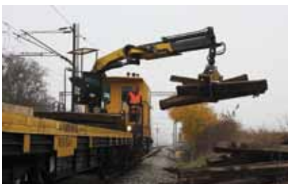
Odvoženje i odlaganje drvenih pragova
