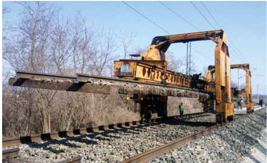
Strojna demontaža tračnica i pragova
