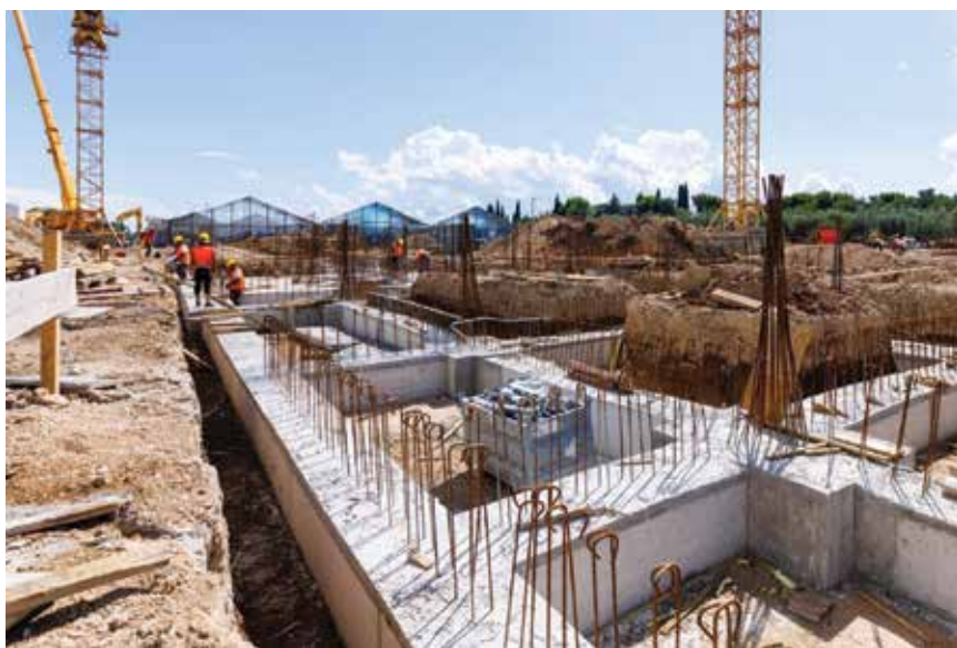
Radovi na temeljenju građevine "A"
