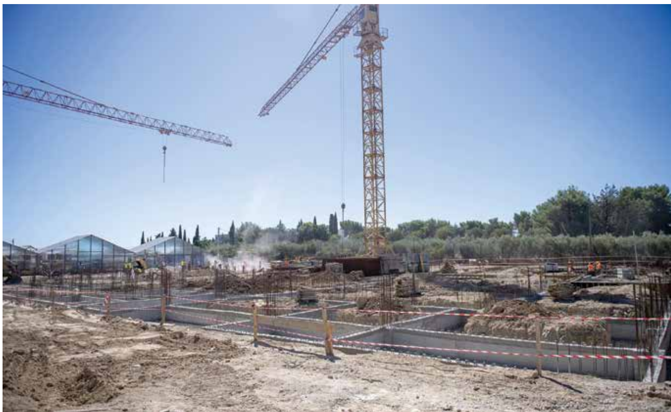
Radovi na temeljenju građevine "A"
