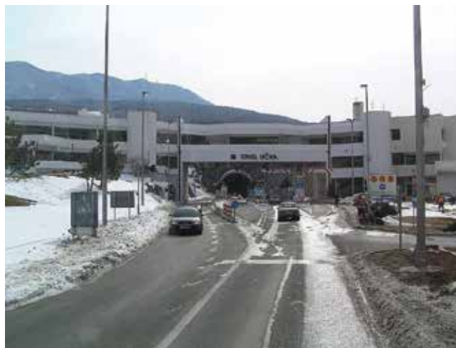
Ulazni portal tunela Učka
