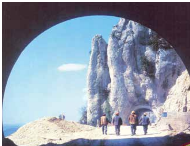
Radnici na gradilištu tunela Učka 1976.
