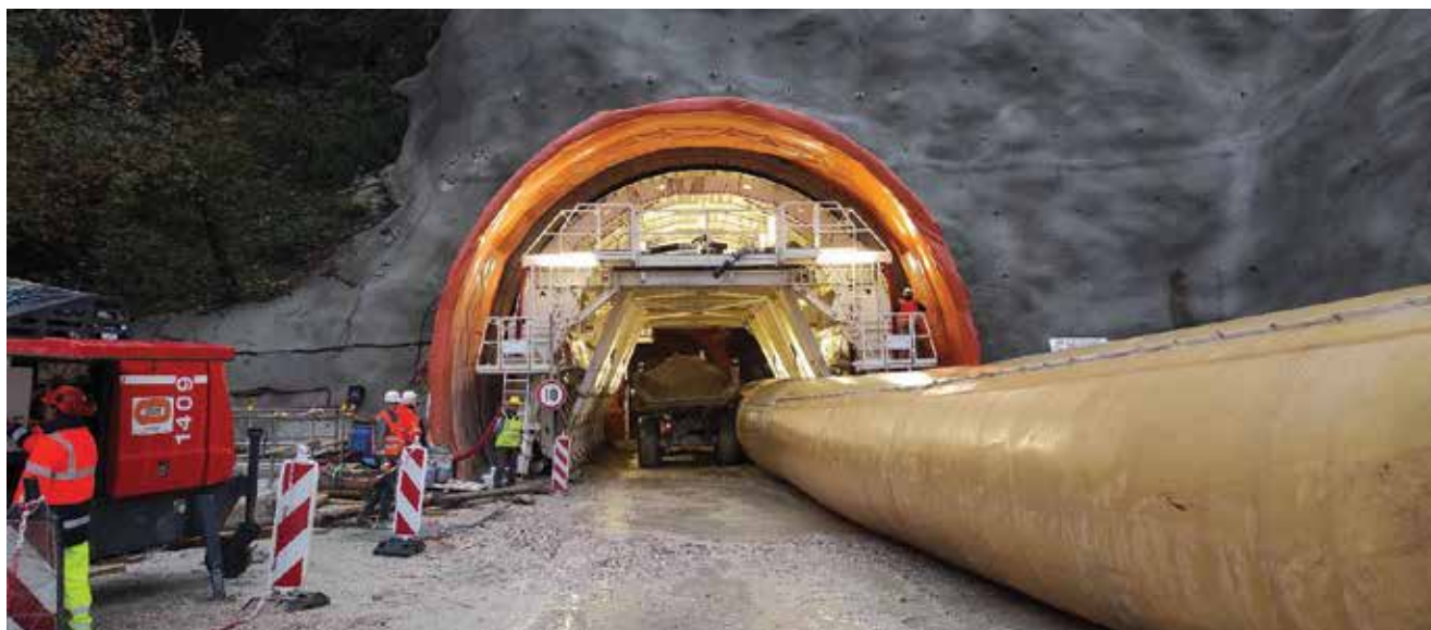
Radovi na hidroizolaciji druge cijevi tunela Učka
