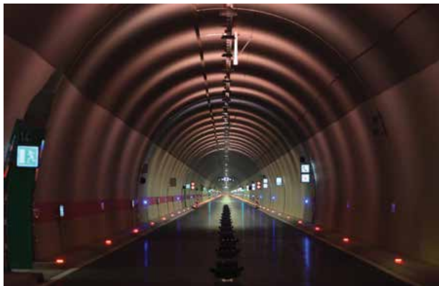
Izgled tunelske cijevi nakon obnove
