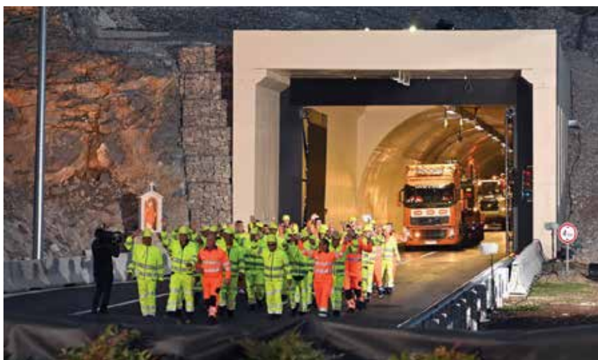
Detalj snimljen tijekom otvaranje druge cijevi tunela
