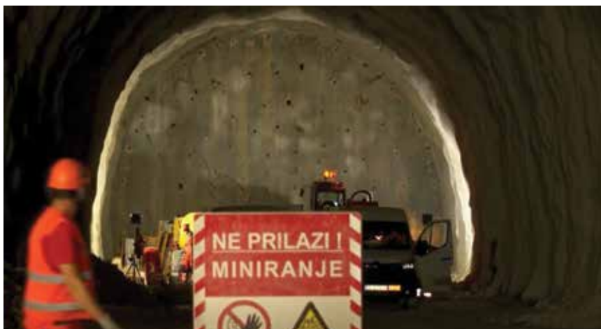
Tijekom gradnje druge cijevi tunela izvedeno je gotovo 2000 miniranja
