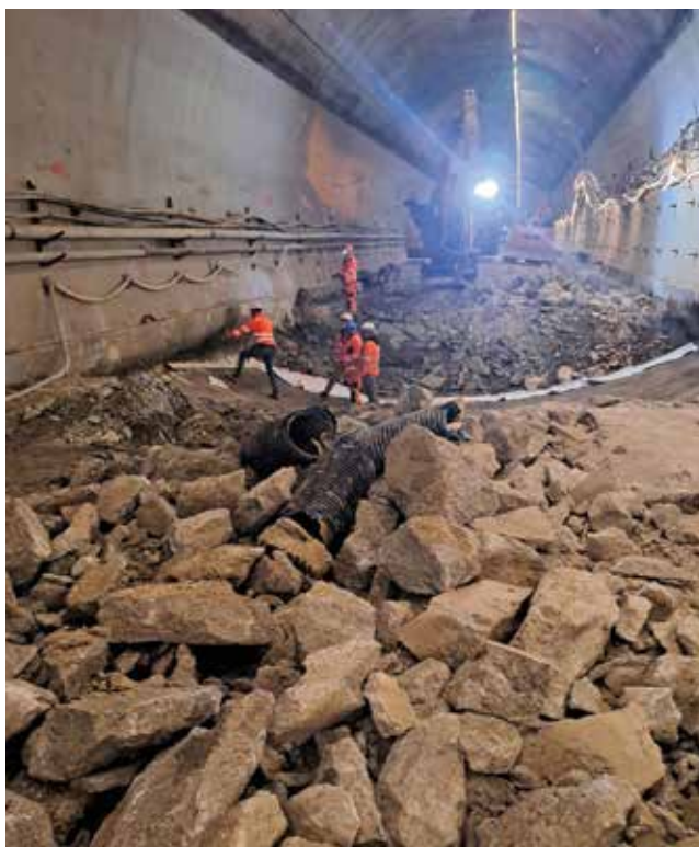
Uklanjanje kolničke konstrukcije u staroj cijevi tunela
