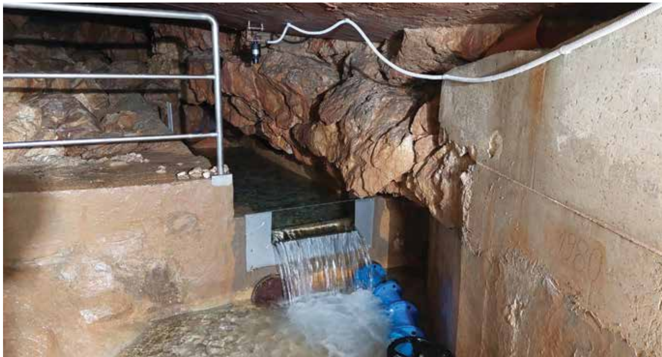
Detalj s gradilišta
