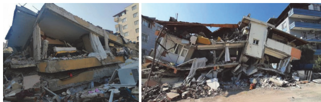
Slika 21. Posljedice sustava "slabi stup – jaka greda" uslijed potresa u Antakiji i Iskenderunu
