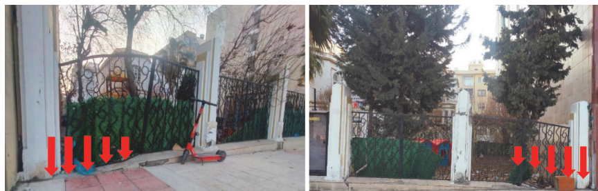
Slika 8. Uslijed potresa u İskenderunu (pokrajina Hatay) uočeni su likvefakcija i izbijanje pijeska
