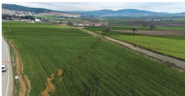
Slika 4. Veliki površinski rasjedi na poljoprivrednome zemljištu nakon potresa u Altınözüu [11,12]
