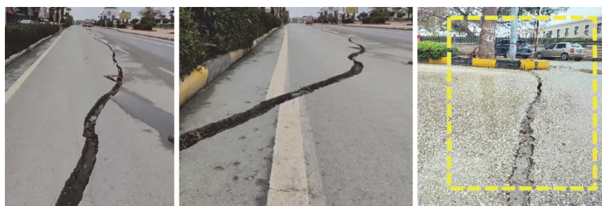
Slika 10. Oštećenja uslijed slijeganja tla zabilježena u priobalnome pojasu pokrajine Hatay
