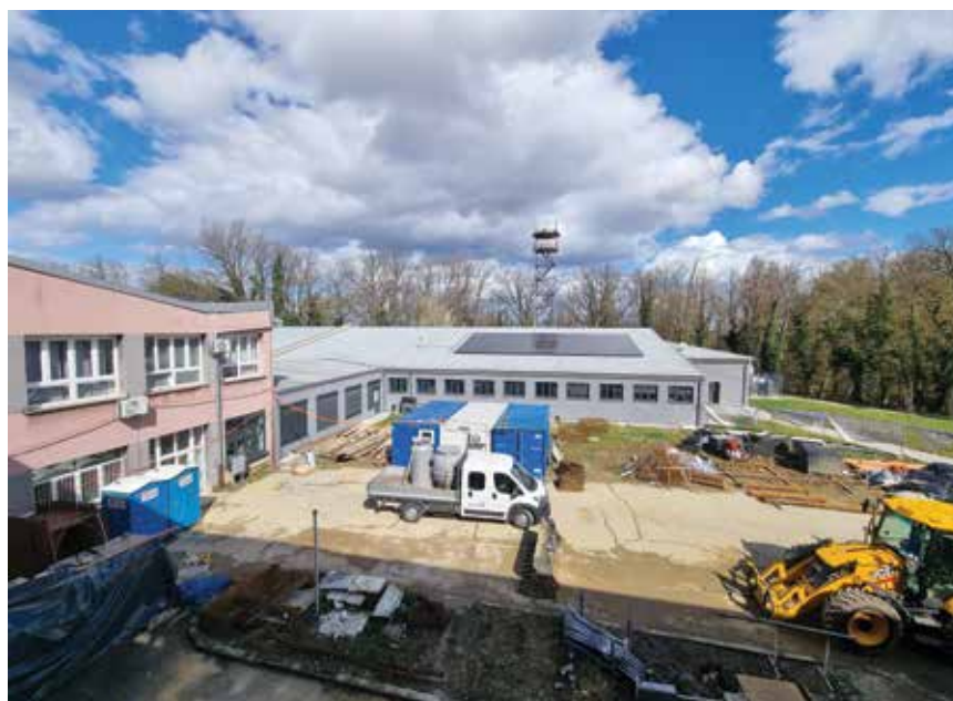
Dio gradilišta s pogledom na završeni Centar za ljevarstvo - SIMET
