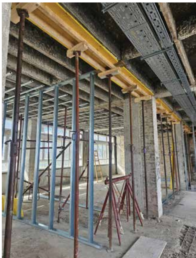
Detalj s gradilišta
