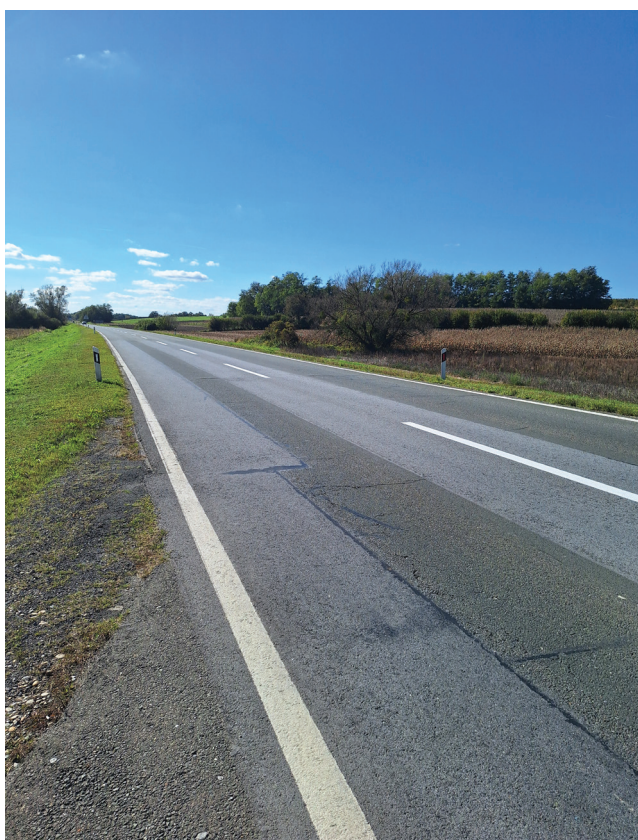
Slika 5. Popravlak lokalnih oštećenja kolnika D28, bjelovarske obilaznice, od km 5+000 do km 5+500
