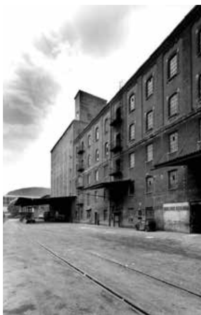
Pogled na dio industrijskog kompleksa
