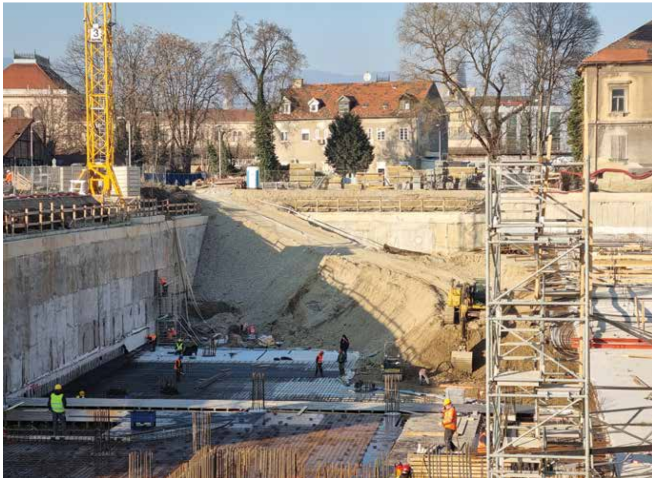
Radovi na novom objektu u zapadnoj dilataciji
