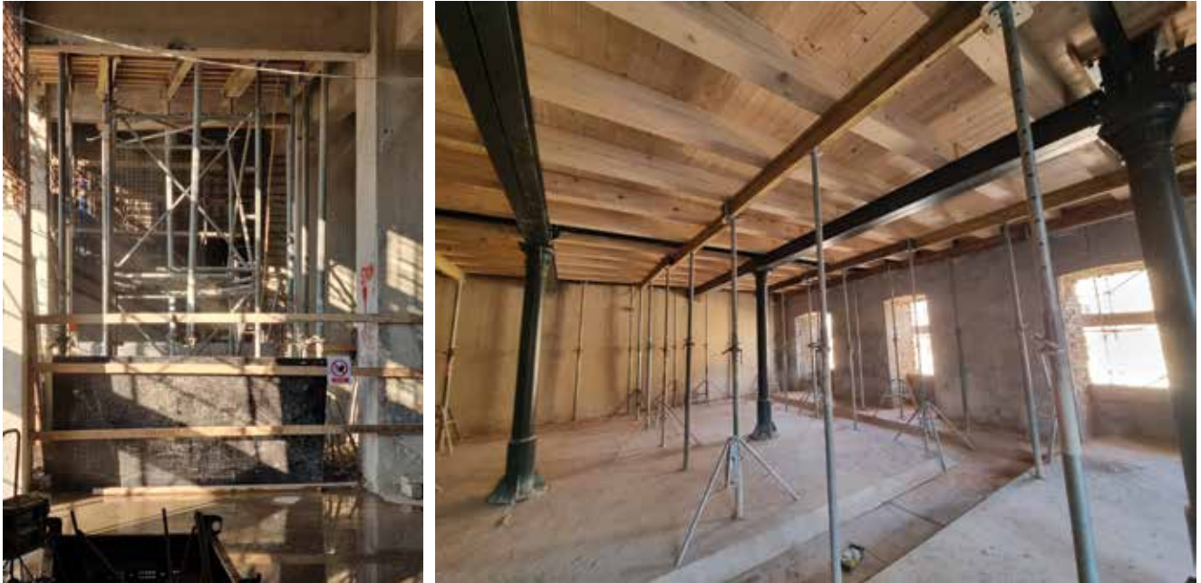
Konstruktivna obnova zgrade transmisije
