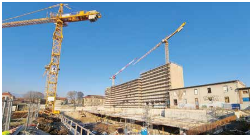
Pogled na postojeće zgrade koje se rekonstruiraju u istočnoj dilataciji
