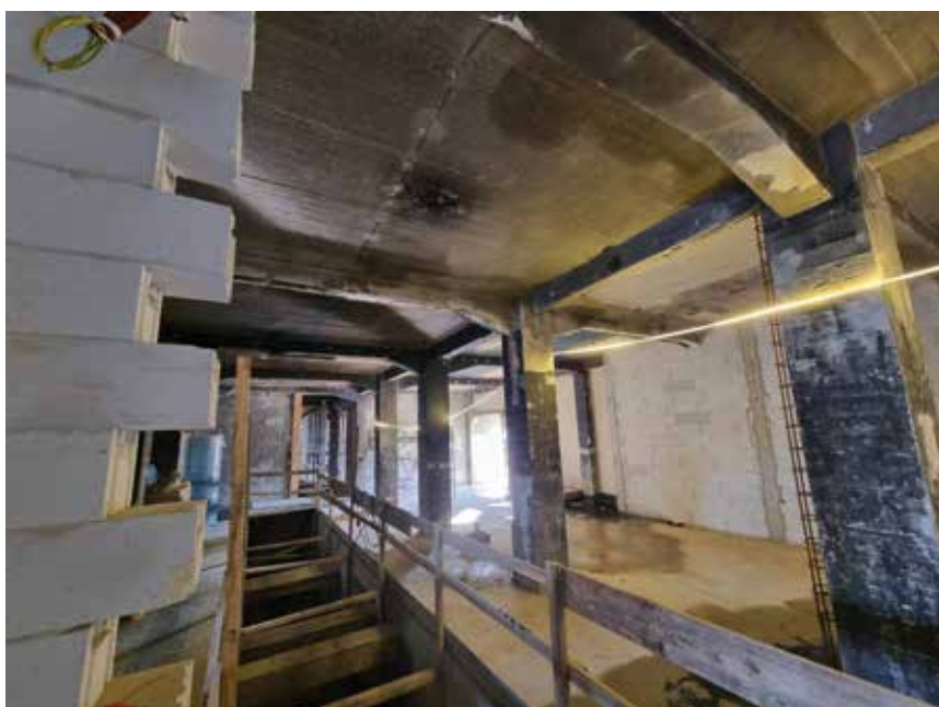
Detalj s gradilišta
