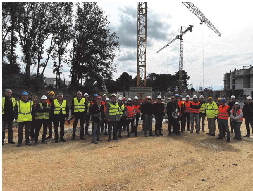
Sudionici stručne ekskurzije na gradilištu hotela Pical
