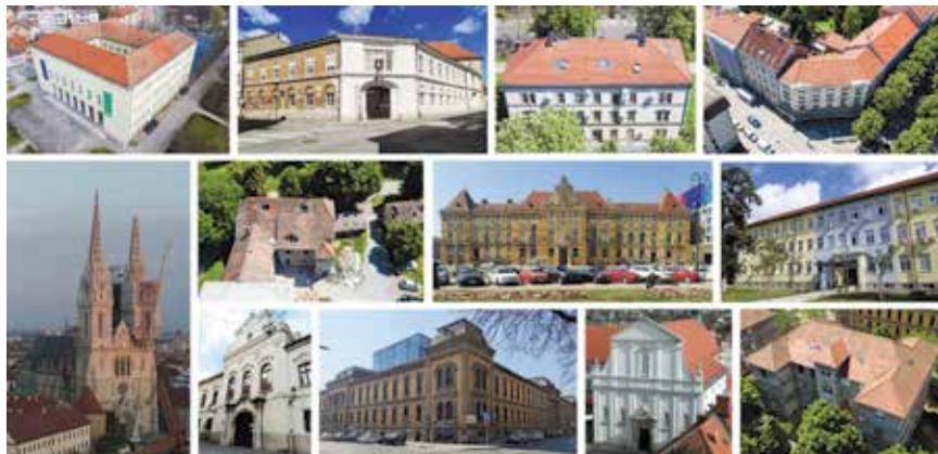
Slika 7. Primjeri zgrada na kojima su provedena ispitivanja plosnatim prešama
