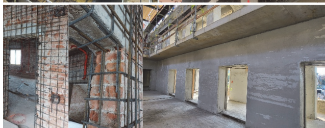
Slika 42. Izvedba radova na ojačanju postojećeg zidanog zida [3]
