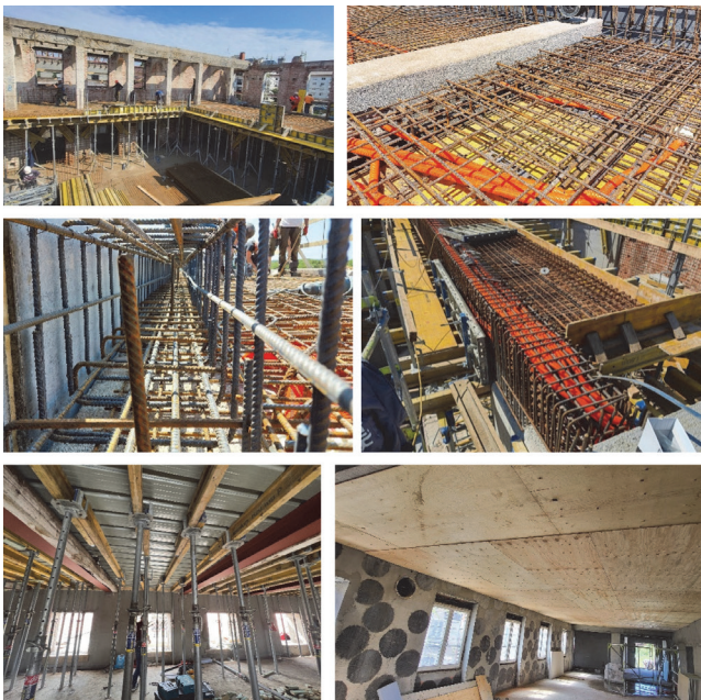
Slika 44. Izvedba radova na novim i pojačanju postojećih stropnih konstrukcija [3]
