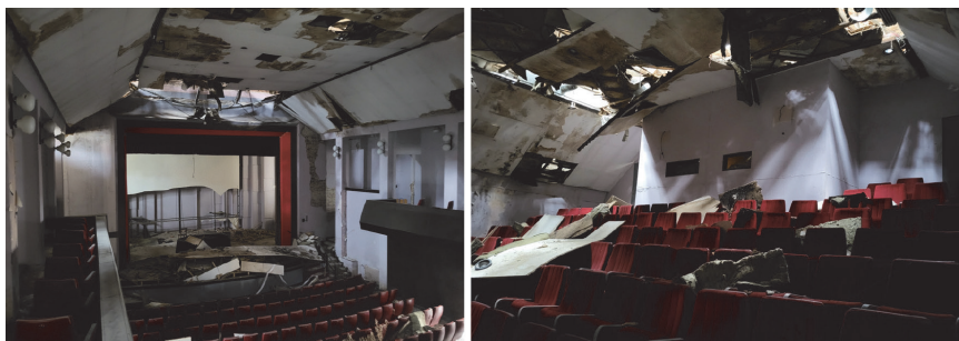
Slika 4. Stanje velike dvorane u trenutku početka realizacije projekta [3]
