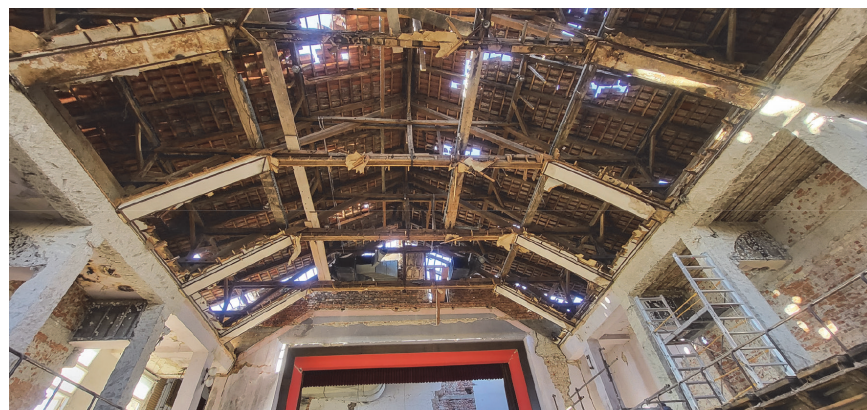
Slika 38. Detalji ojačanja postojeće drvene krovne konstrukcije [12]
