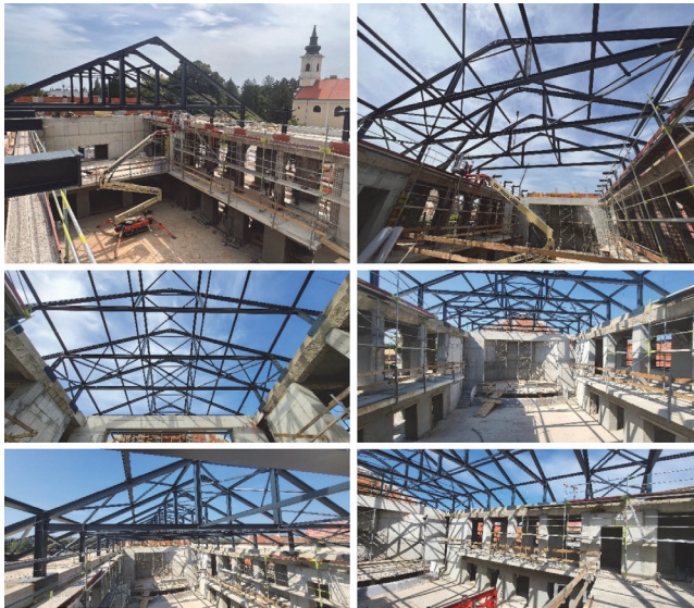
Slika 43. Izvedba radova na novoj čeličnoj krovnoj konstrukciji dvorane [3]
