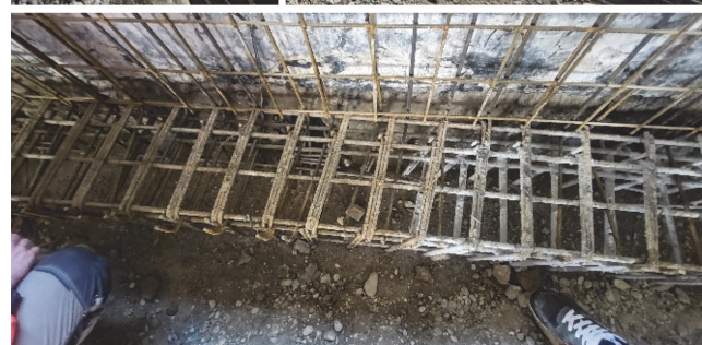
Slika 40. Izvedba radova na ojačanju temeljne konstrukcije [3]
