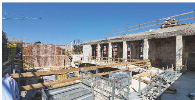
Slika 41. Zatečeno stanje postojeće konstrukcije velike dvorane nakon uklanjanja drvenog krovišta [3]
