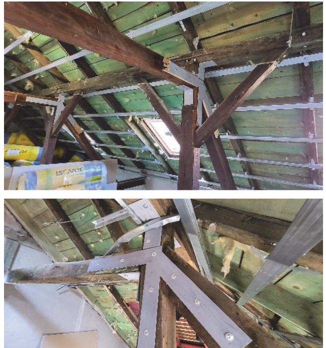
Slika 45. Izvedba radova na pojačanju postojećeg drvenog krovišta [3]
