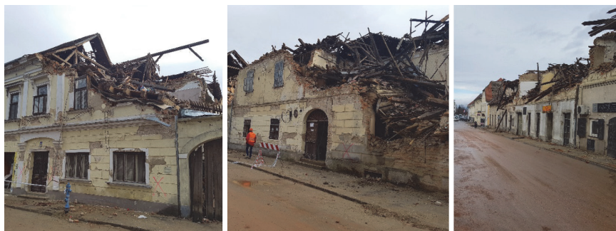
Slika 6. Stupanj oštećenja IV (DS IV) s mehanizmima OIR-a [17]
