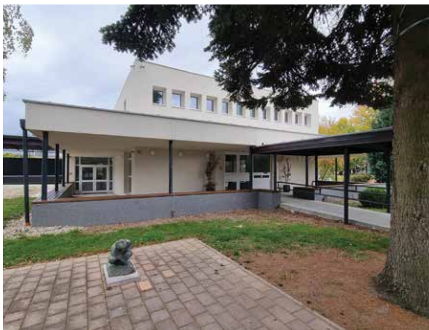
Pogled na obnovljeno Kazalište 21 u Sisku
