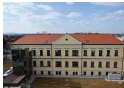
Zgrada stare interne nakon završetka obnove
