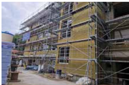
Detalj s gradilište zgrade nove interne
