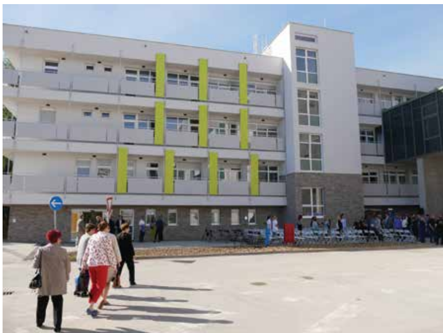
Zgrada nove interne nakon završetka obnove
