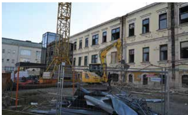
Zgrada stare interne tijekom radova na obnovi
