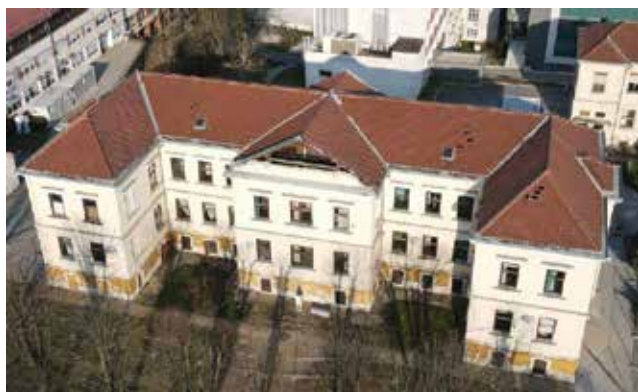
Uklonjeni dimnjaci na krovnoj konstrukciji
