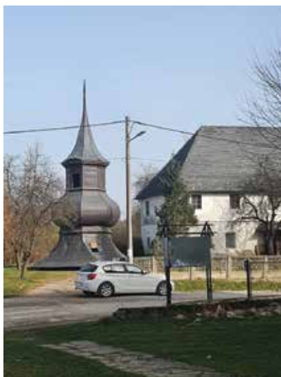
Demontirana kapa zvonika u dvorištu župne kuće u Maloj Gorici
