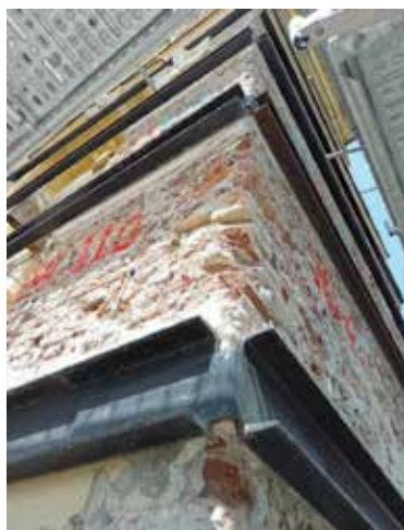
Detalji čeličnih obruča oko zvonika kao dio hitnih mjera stabilizacije građevine
