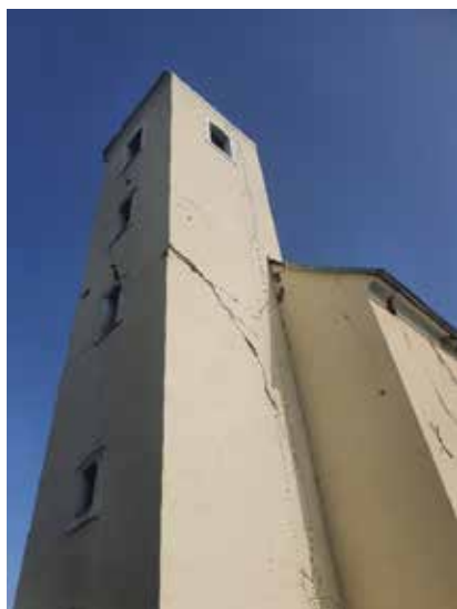
Teško oštećeni zvonik crkve sv. Jurja u Maloj Gorici, koji je uklonjen tijekom hitnih mjera
