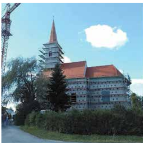
Crkva snimljena tijekom obnove, rujan 2024.
