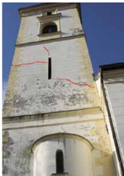
Crkva Gospe Snježne u Dubrancu – numerički model iz push-over analize uspoređuje se sa stvarno utvrđenim oštećenjima
