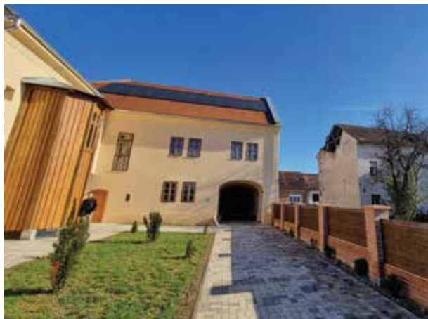
Obnovljeno pročelje slikano u studenom 2025.
