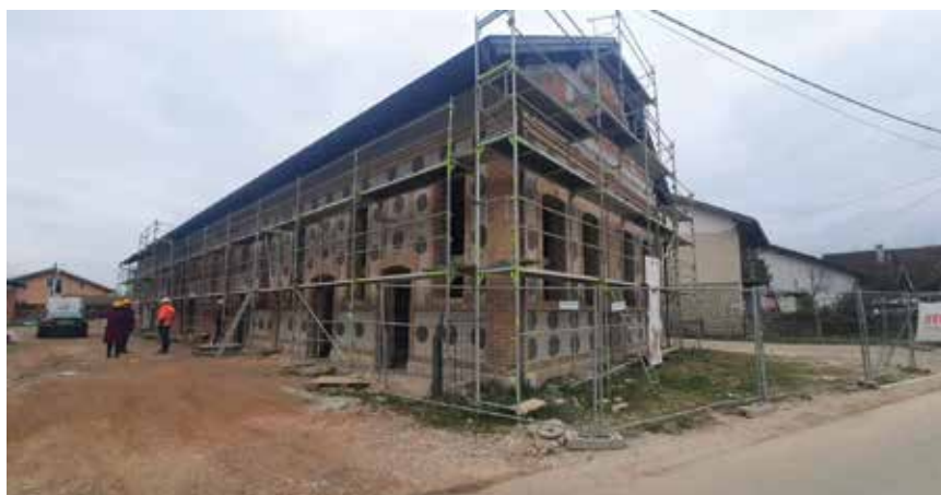
Detalj s gradilišta
