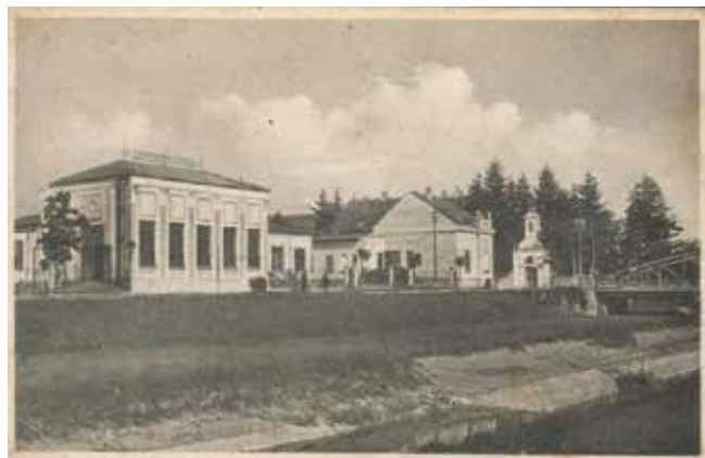
Zgrada munjare na razglednici s početka 20. stoljeća
