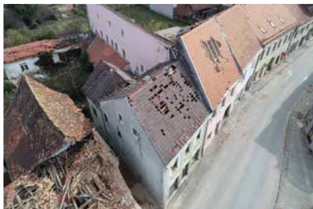
Oštećenja od potresa snimljena iz zračne perspektive
