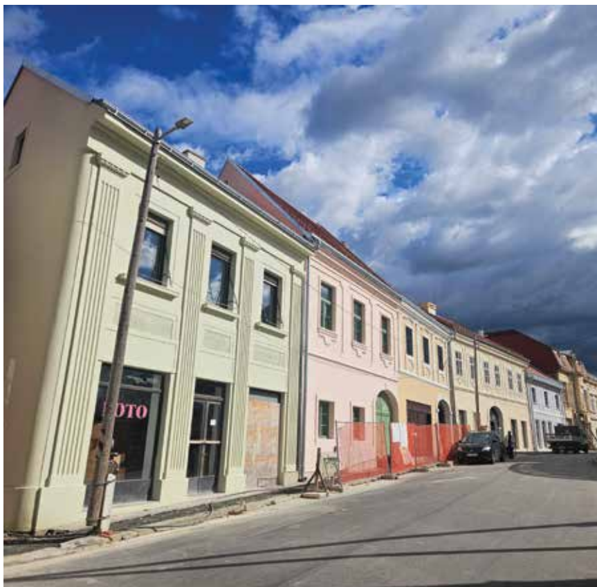
Pogled na obnovljenu zgradu u povijesnoj jezgri grada Petrinje
