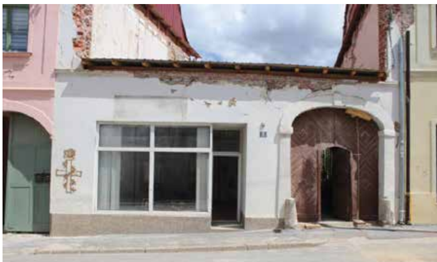
Ulično pročelje nakon provedbe hitnih mjera sanacije
