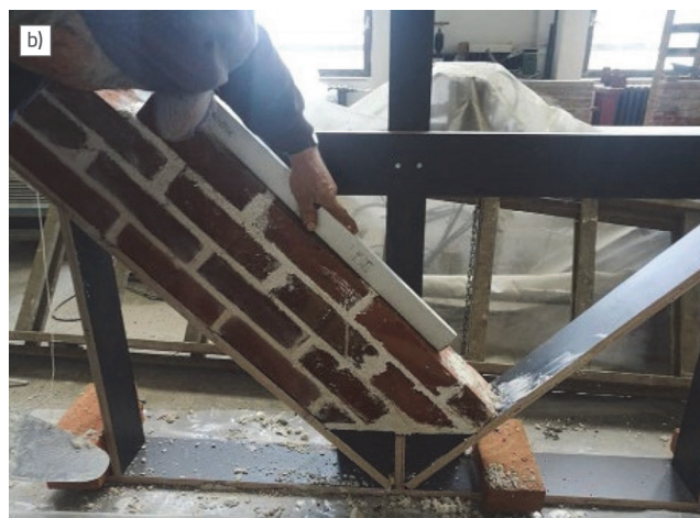
Slika 8. Izgradnja oplata od šperploče i uzorka za ispitivanje dijagonalne vlačne čvrstoće zidova: a) Crtež modela oplata od šperploče; b) Izvedba zidanih panela
