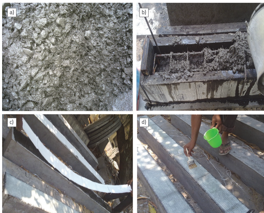
Slika 2. Izrada greda i pojačavanje u tijeku
