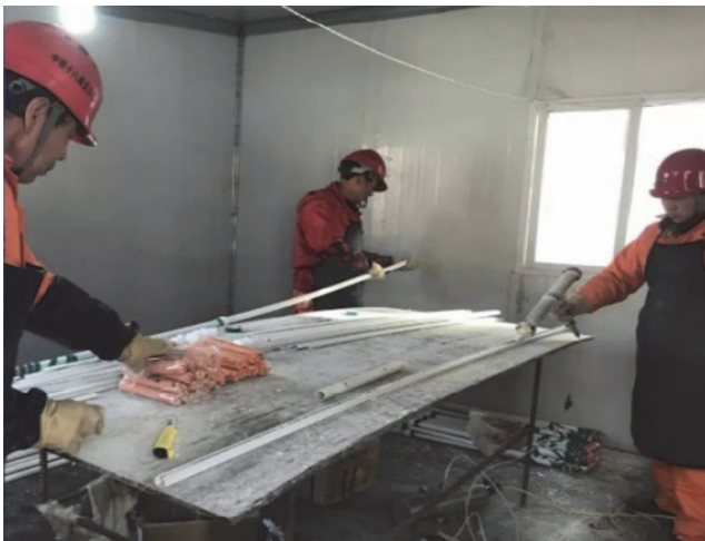
Slika 11. Postupak punjenja cijevi kumulativnog naboja
