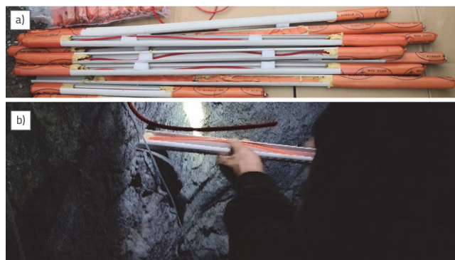
Slika 17. Punjenje i ugradnja cijevi s kumulativnim nabojem: a) Punjenje cijevi kumulativnim nabojem; b) Ugradnja na terenu
