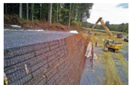
Izgradnja potporne konstrukcije za bušotinski radni prostor u Gornjim Plavicama
