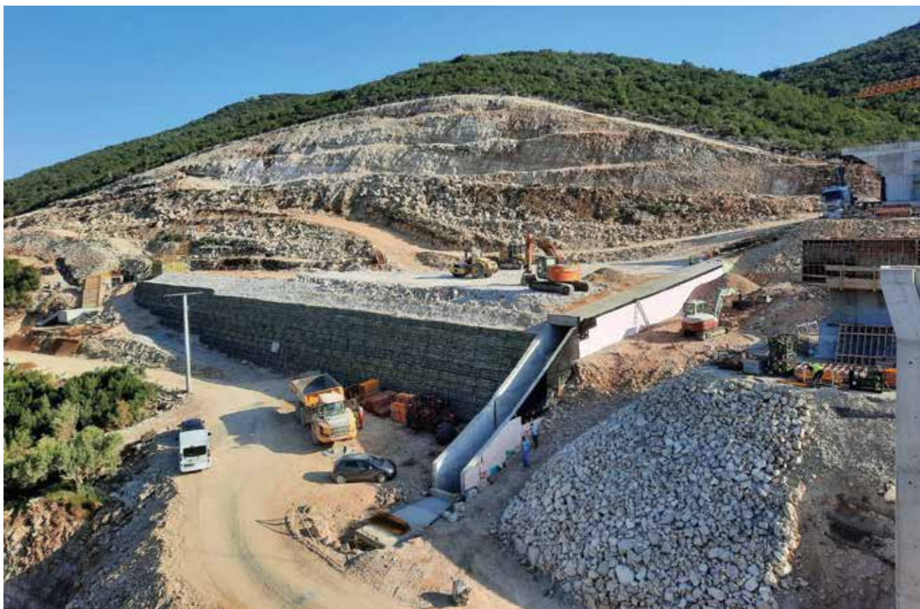
Primjer gradnje armiranoga zida na pristupnim cestama Pelješkome mostu kod Brijeste, izvođač radova Strabag uz stručni suport Kotonteks i Tenax
