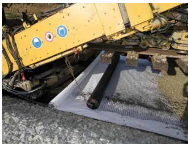
Postavljanje geokompozita na pruzi Dugo Selo – Borongaj, izvođač Swietelsky
