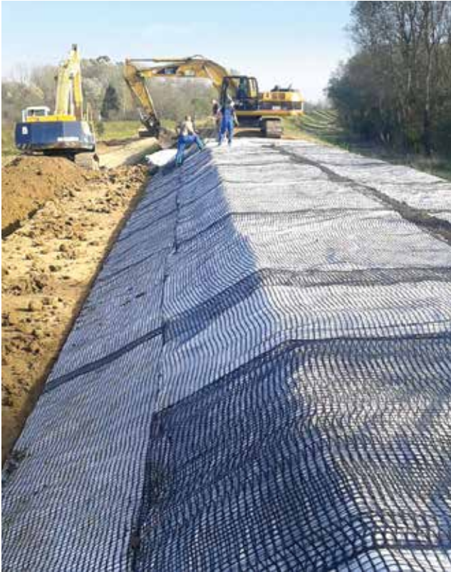
Izvođenje radova rekonstrukcije nasipa Virje Otok – Brezje na Dravi, duljine 3,7 km, izvođač radova Vodogradnja Varaždin i Hidrotehnika Čakovec
