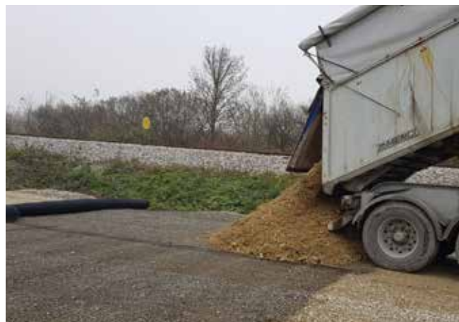
Modernizacija i elektrifikacija željezničke pruge na dionici Zaprešić - Zabok
