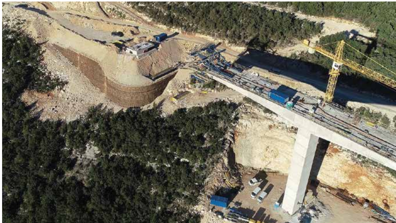
Zračni snimak potporne konstrukcije na gradilištu mosta, Jaruge Pelješac, izvođač radova Strabag uz stručni suport Kotonteks i Tenax
