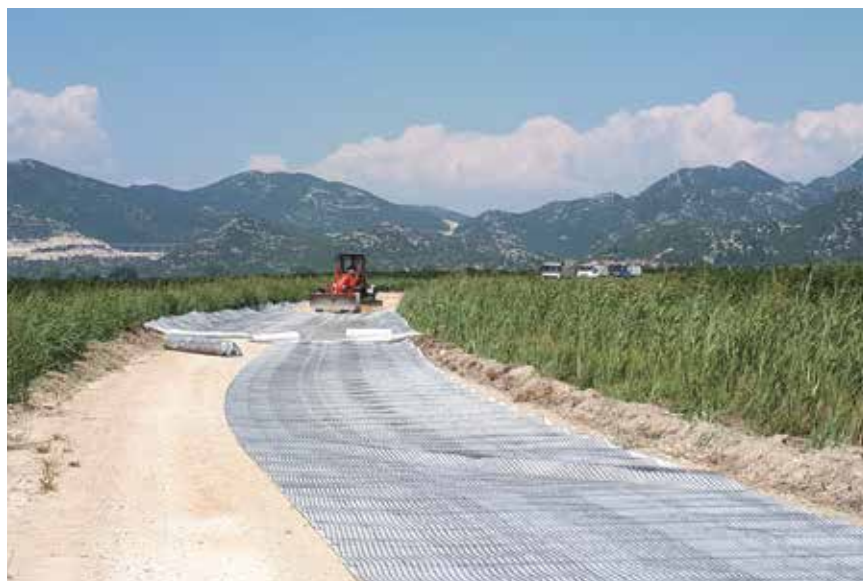
Rekonstrukcija nerazvrstane ceste NC97 Jasenska kroz dolinu rijeke Neretve kod Opuzena, primjena geokompozita (geomreža sa geotekstilom), izvođač radova Strabag uz stručni suport Kotonteks
