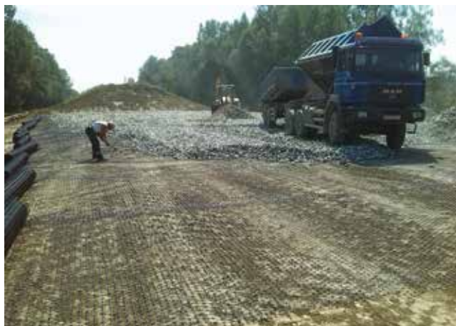
Postavljanje dvoosne geomreže u retenciji Lonjsko polje, izođač radova Lapor iz Velike Gorice
