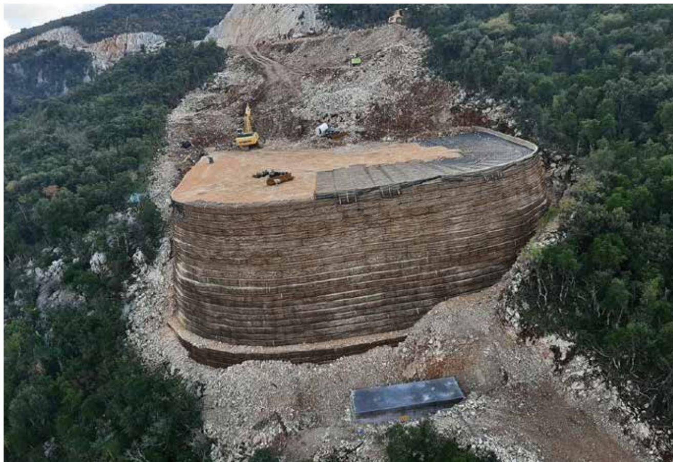
Detalj s gradilišta Jaruge Pelješac, izvođač radova Strabag uz stručni suport Kotonteks i Tenax
