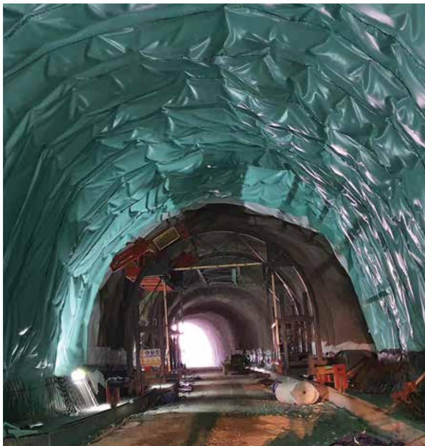
Hidroizolacija tunela Kamenice, Pelješac 2022., izvođači radova Kotonteks i Strabag
