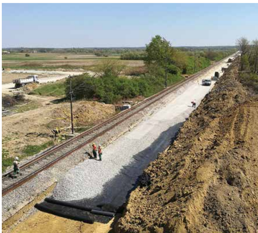
Ojačanje tla za gradnju donjega ustroja željezničke pruge na dionici Vrbovec – Križevci
