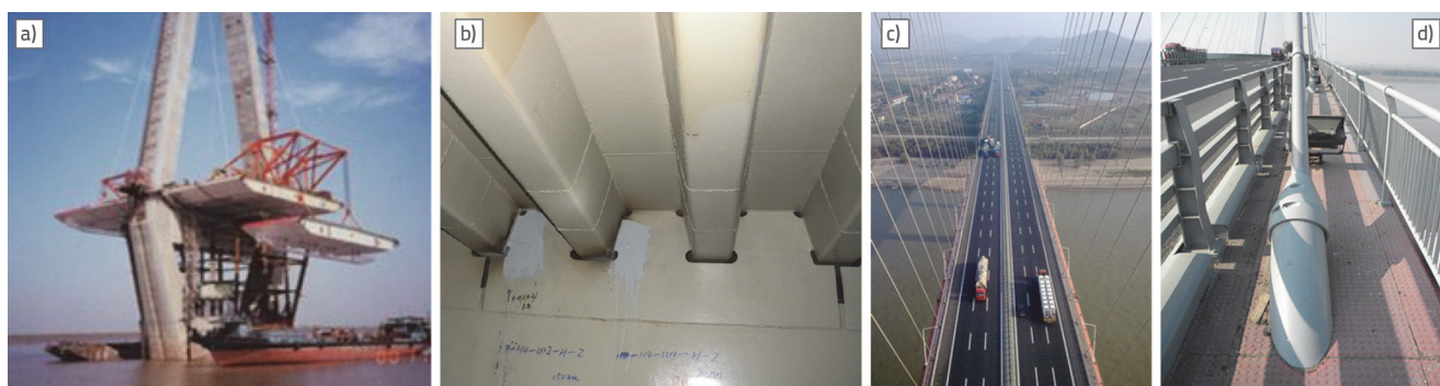
Slika 2. Detalji Mosta Junshan preko rijeke Jangce u Wuhanu: a) podizanje čeličnog sandučastog nosača; b) zavareni detalj u čeličnom sandučastom nosaču; c) ploča mosta; d) kabel
