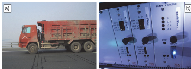
Slika 4. Sustav WIM instaliran na mostu: a) WIM; b) Demodulator
