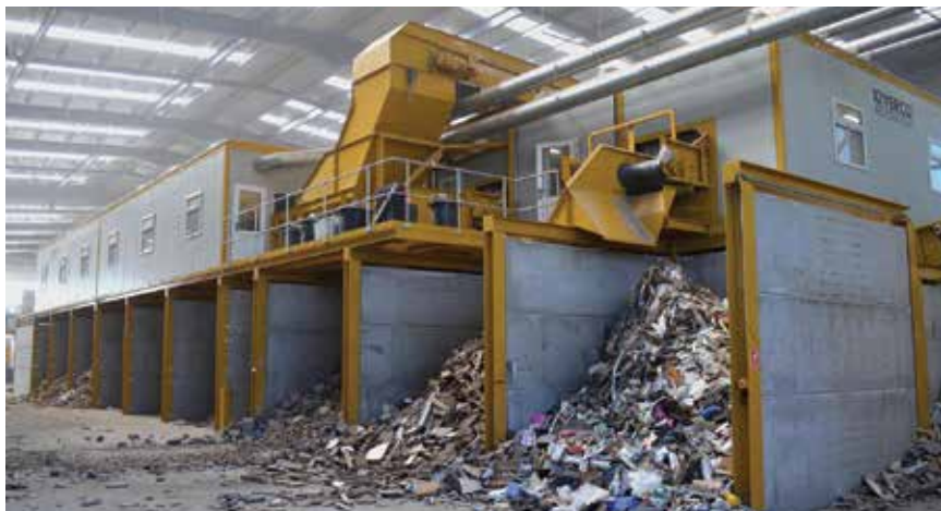
Postrojenje za preradu građevnog otpada
