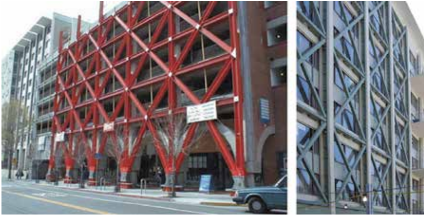
Slika 8. Zgrade ojačane vanjskim čeličnim vezovima
