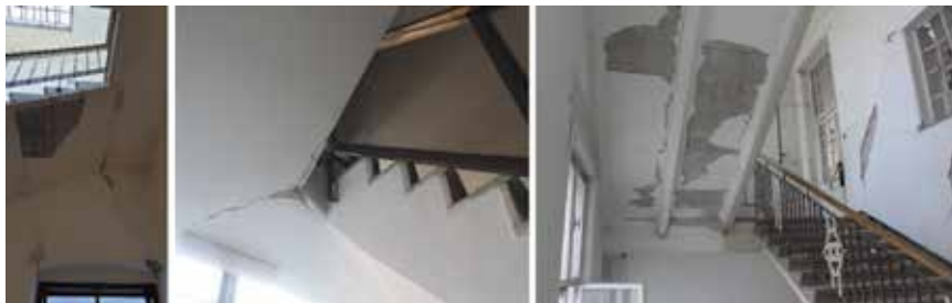
Slika 25. Oštećenja stubišta [39]
