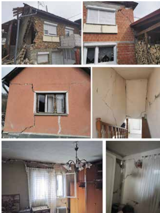
Slika 28. Oštećenja kuća u MO Vidovec, GČ Podsljeme (autor fotografija: Luka Božić i [39])
