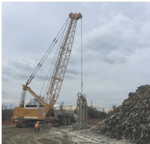
Slika 6. Fotografija opreme za iskop dijafragme, uvodnog kanala i uvodnog lijevka
