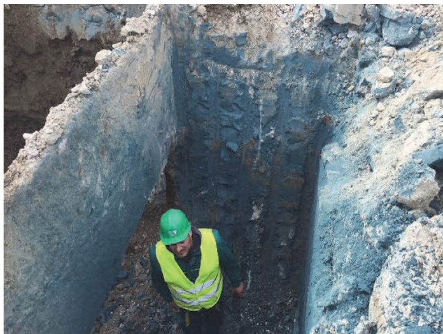
Slika 10. Probni iskop za pregled penetracije glinobetonske smjese u okolno tlo
