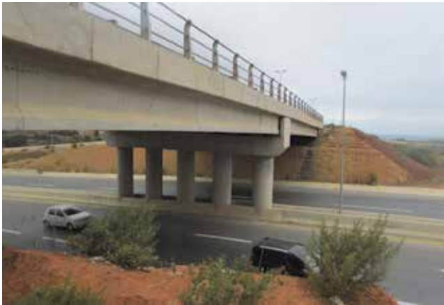
Slika 5. Pogled na analizirani most
