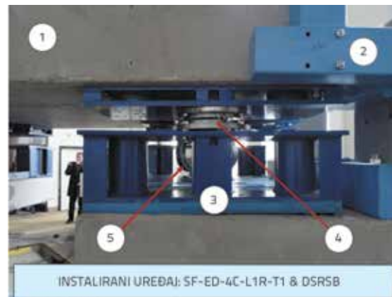
Slika 10. Detalj uređaja spremnog za ispitivanje: (1) rasponska konstrukcija; (2) čelični nosač uređaja DL; (3) čelični nosač uređaja DSR5B; (4) uređaj DSR5B; (5) uređaj SF-ED-4C-L1R-T1
