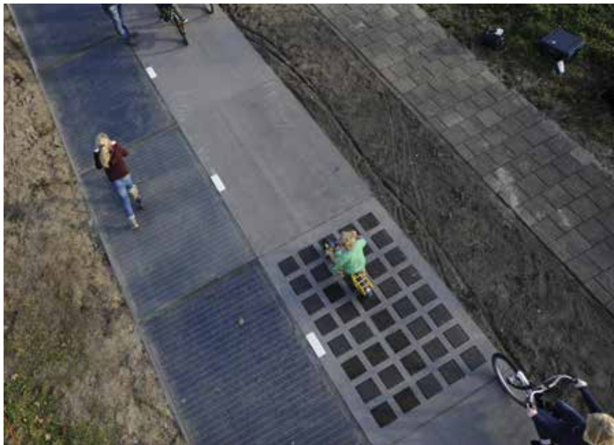
SolaRoad u Nizozemskoj
