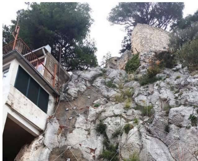
Sanacija stijena iznad naseljenog područja
