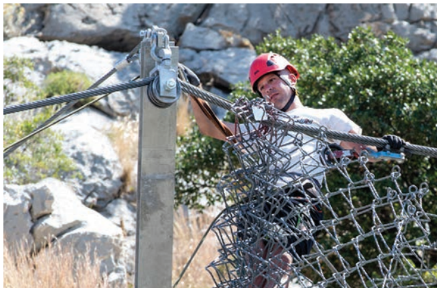
Montaža čelične mreže
