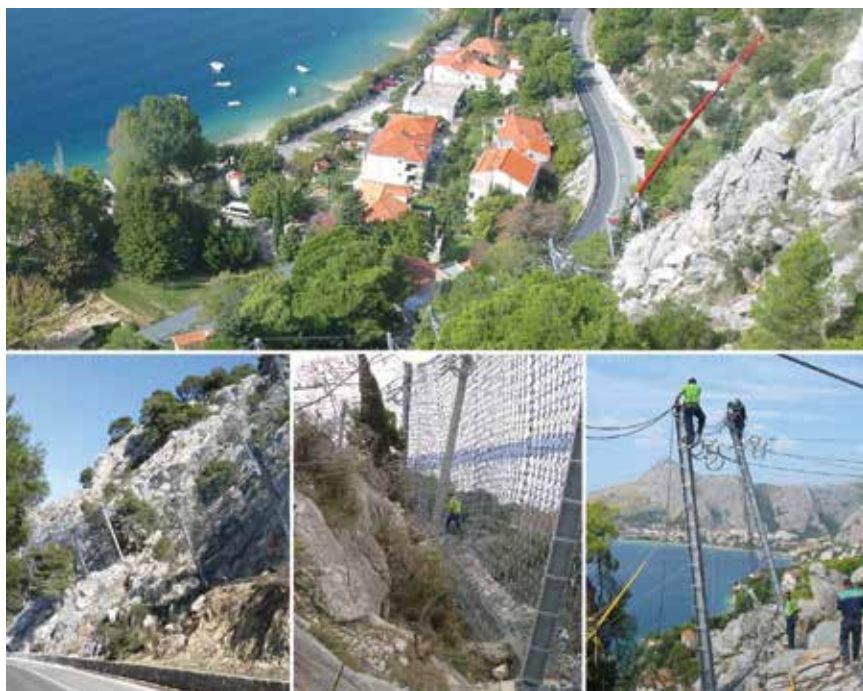
Detalji s gradilišta
