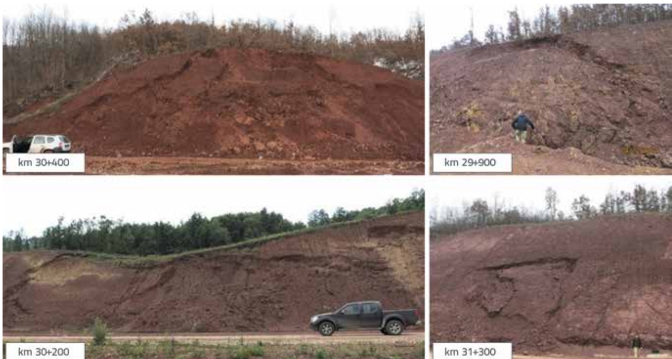
Slika 2. Tipični lomovi u permskom šejlu i mulnjaku
