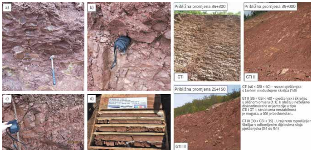
Slika 6. Stijenska masa, neizložena vremenskom utjecaju, u glavnom ožiljku klizišta: a) km 30+200, b) 28+650, c) 26+300, d) jezgra izvađena iz bušotine na km 30+200 i tipični permski predstavnici (desno)
