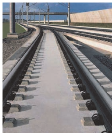
Slika 4. Kolosijek na čvrstoj podlozi Rheda 2000
