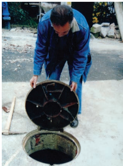
Poklopac na "pant", otvoren ima "nos", a okvir utor pa ne "lupa" niti se može ukrasti
