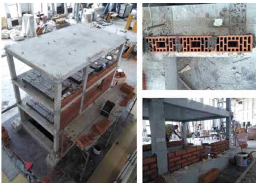
Slika 1. Izvedba šupljeg opečnog ispunskog zida [4]
