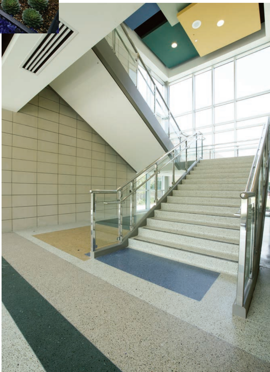
Ploče od mljevenog stakla i porculana služe umjesto klasičnih keramičkih pločica, a posebno su pogodne kao obloge kod podnog grijanja, primjerice u školama
