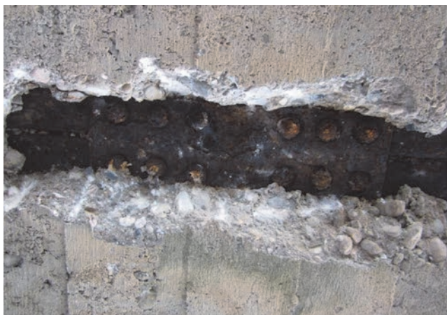
Slika 8. Nastavak krute armature
