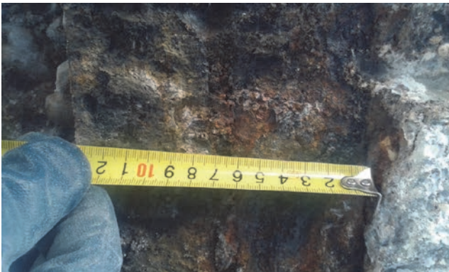
Slika 19. Kruta armatura
