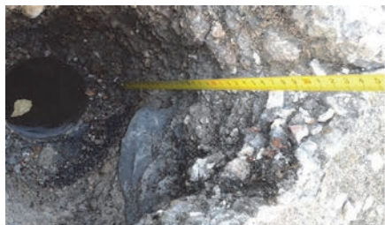
Slika 24. Hidroizolacija od bitumena
