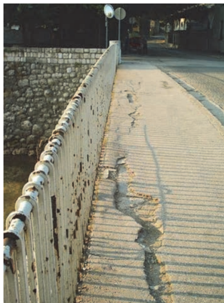
Slika 10. Korozija čelične ograde i oštećenje pješačke staze
