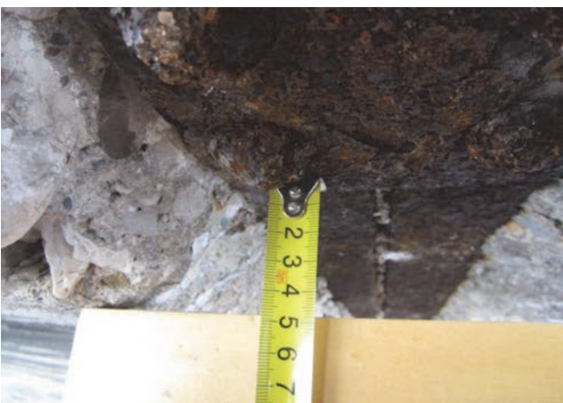
Slika 20. Debljina zaštitnog sloja betona
