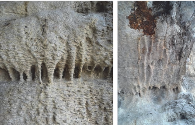
Slika 18. Naslage na desnom upornjaku - istočna strana
