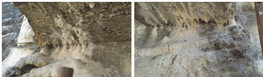
Slika 17. Naslage na lijevom upornjaku - istočna strana
