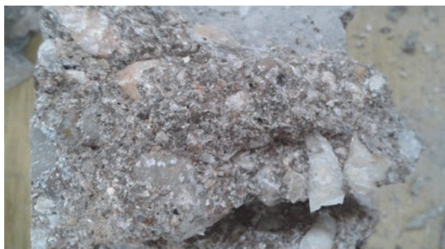
Slika 31. Procjeđivanje kroz beton
