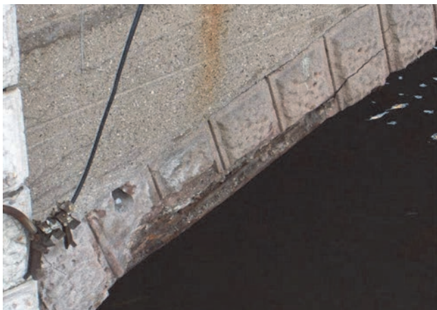
Slika 12. Horizontalne pukotine na zidovima: istočna fasada - uzvodna strana
