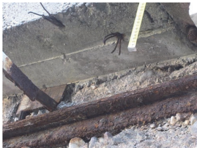
Slika 9. Korozija gornje krute armature - istočna fasada - uzvodna strana.
