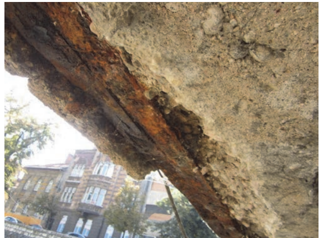
Slika 13. Korozija krute armature luka s donje strane: istočna fasada - uzvodna strana
