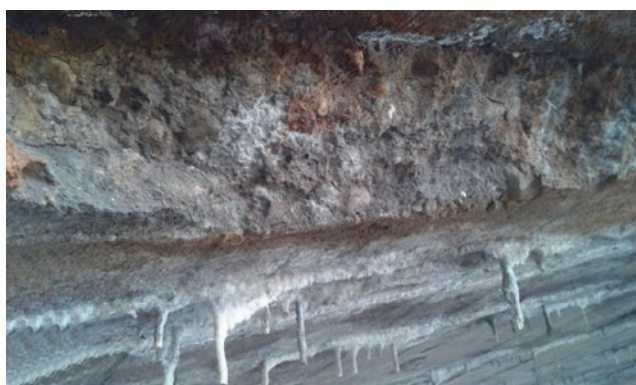
Slika 16. Karbonizacija intradosa i formiranje stalaktita
