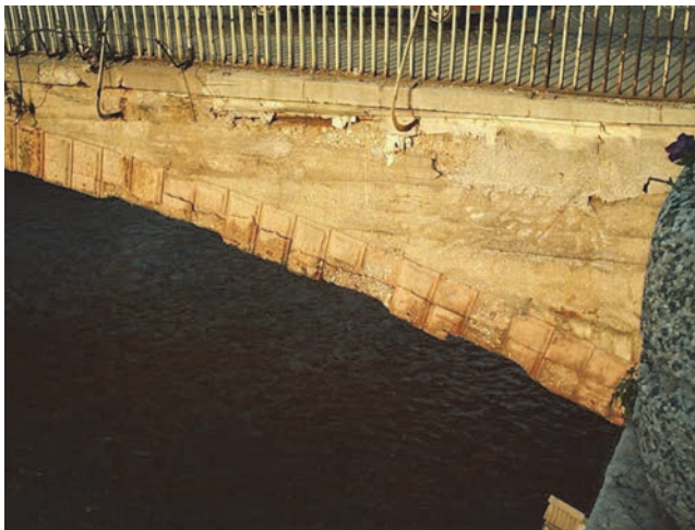
Slika 11. Odvajanje dekorativnih elemenata, horizontalne pukotine u betonu na luku i korozija nosača ograde-istočna fasada-uzvodna strana
