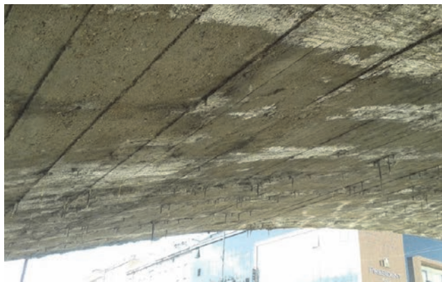
Slika 15. Karbonizacija intradosa i formiranje stalaktita
