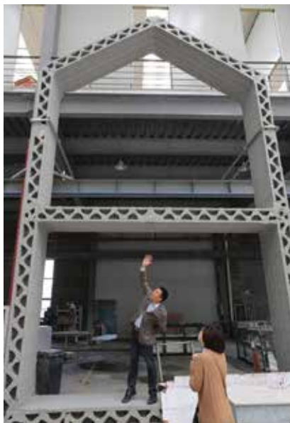
Isprintani betonski element od recikliranog materijala
