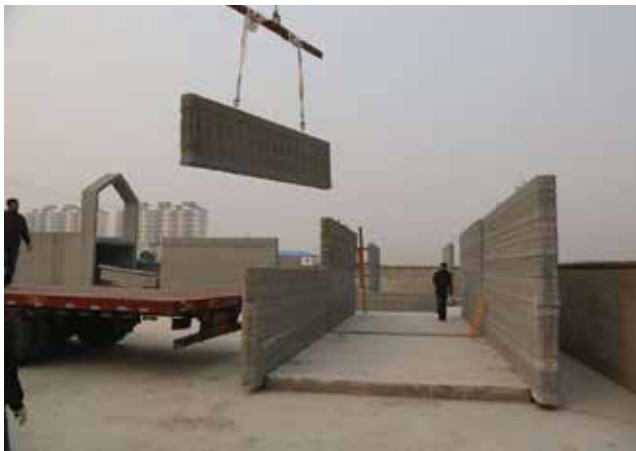
Detalj s gradilišta u Šangaju
